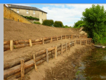
Automne 2012 : retalutage en paliers
