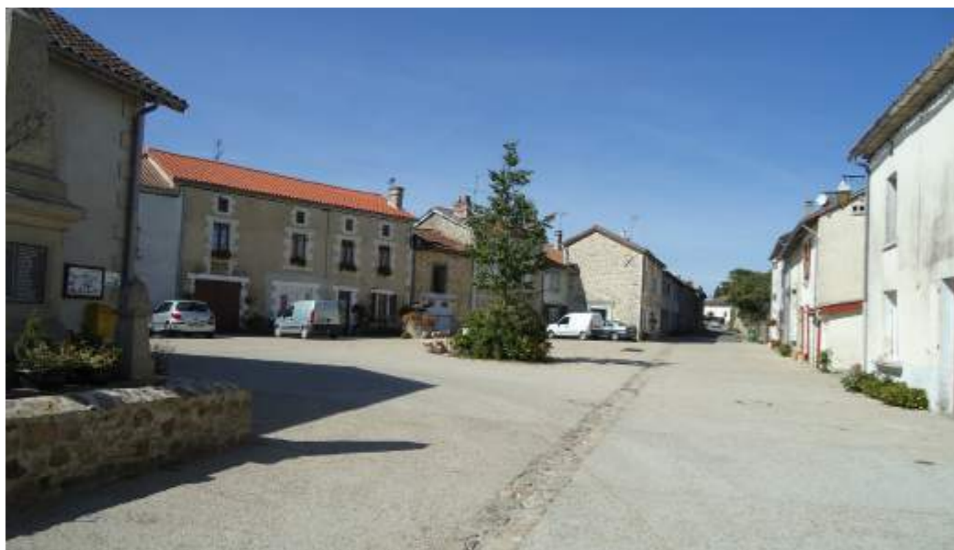
Place carrefour en béton désactivé - Maisonnais sur Tardoire (87)
