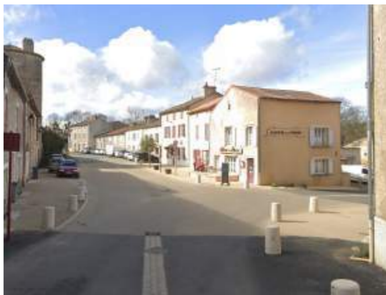
Enrobé revêtu de résine Place des Tilleuls - Château Larcher (86)
